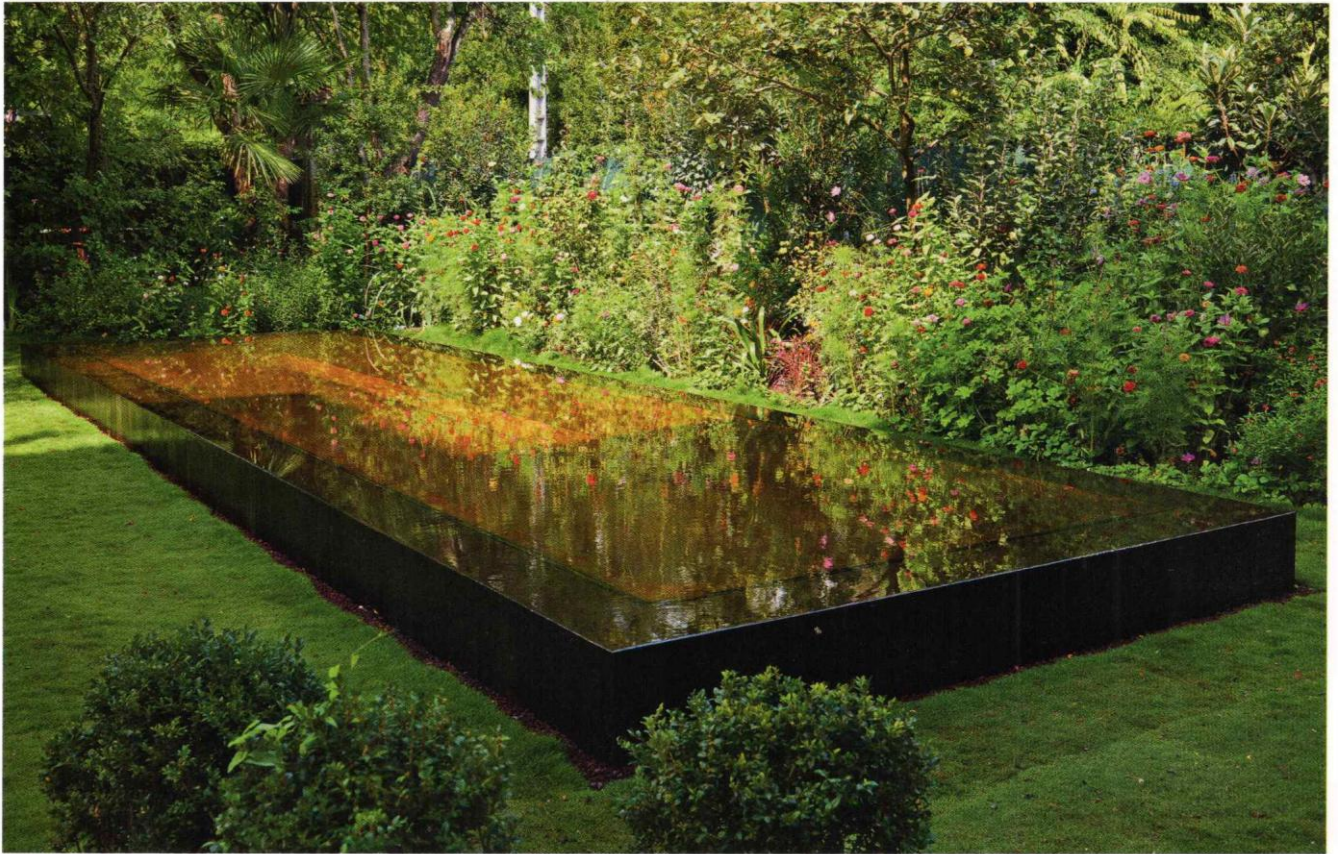
Plus bassin que piscine, ce couloir de nage joue l'intégration totale. A débordement, avec des rebords en acier corten et un fond mobile, c'est une baignade naturelle dont la filtration est assurée par les plantes. Création Elodée .
