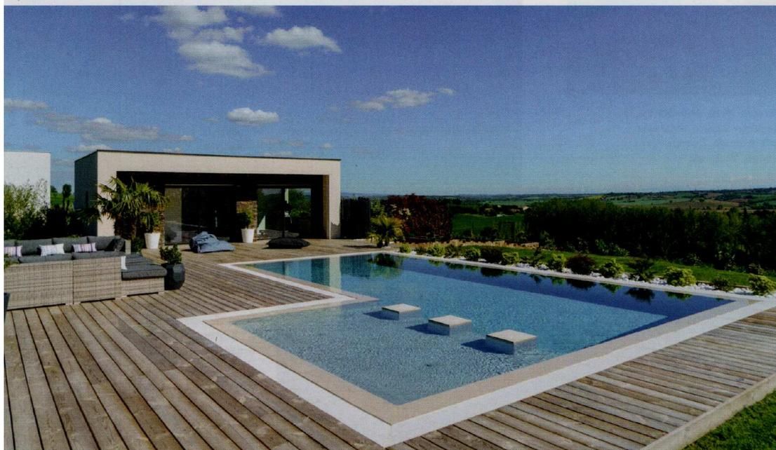
**Géométrique.** Familiale, cette piscine en gunite (béton armé projeté) avec revêtement Quartzroc® HPM Gris se compose d'un grand bassin de 9x4 m et d'un petit de 2,5x3,5 m offrant une plage immergée. Ils sont séparés par des plots assurant la sécurité.
