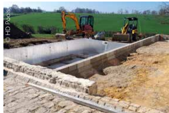
Le nouveau bassin prend place sur l'existant afin de limiter les terrassements.
