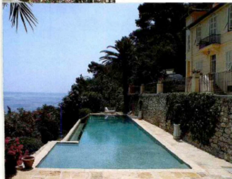
EN TERRASSE Piscine à débordement en béton gunité, revêtue de "Crystalroc" des Alpes vert marbré avec plage immergée, margelles en dalles de pierre reconstituée sculptée "Diffarec". 16 x 4,50 m, 100 000 €, Diffazur.
