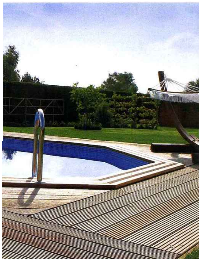
Cette piscine enterrée se compose d'une structure en pin rouge, de plages en garapa et de margelles en iroko Wood-Line .
