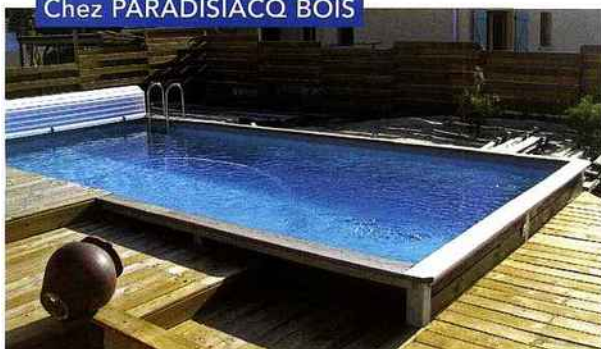
Paradisiacq bois utilise, pour les piscines, une structure en acier galvanisé et des madriers en pin massif, traités classe IV.
