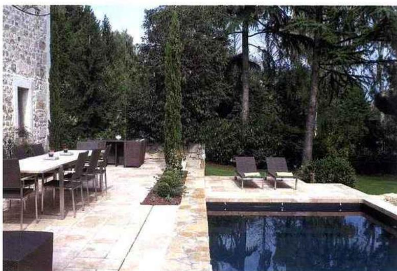
*Projet très personnalisé où la pierre est reine : pierre sèche pour les murets de la piscine et pierre naturelle de Bourgogne pour la margelle. Bassin de 10 x 4 m, avec un escalier sur la largeur, membrane armée noire. Traitement par électrolyseur au sel avec régulation automatique de pH et Redox. Chauffage par pompe à chaleur, couverture de sécurité (Carré Bleu).*
