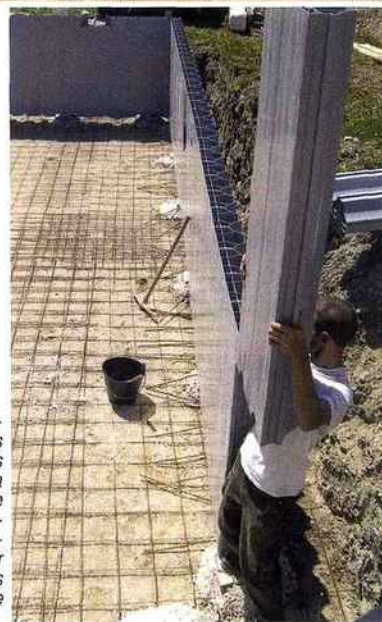
Structure à panneaux de polypropylène, destinée à recevoir un double ferraillage et une épaisseur de béton de 14.5 cm. Ces modules-panneaux à clipser ont une hauteur de 1,20 m ou 1,50 m. Il est possible d'intégrer un caisson de volets roulants, de prévoir un débordement et de créer tous types d'escaliers. Structura d'Everblue.
