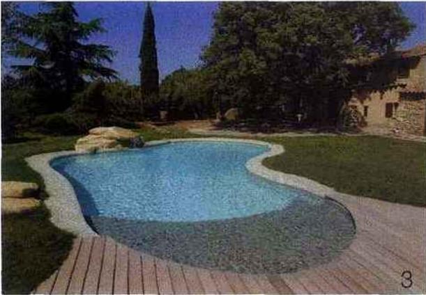
3. Réalisé en béton armé, de forme libre avec escalier maçonné et revêtement intérieur silico-marbreux blanc avec bandeau de galets
