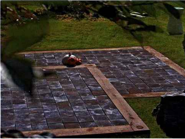
Un pavage en bois debout durable de Canjaere. Grâce à un procédé d'imprégnation, les pavés en chêne profitent de performances accrues et d'une grande durabilité.
