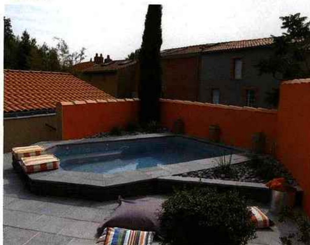
▼ // Mini-Piscine béton, volet intégré sous terrasse (VIST) - liner gris - 2 x 6 m - Réalisation : CARON PISCINES
