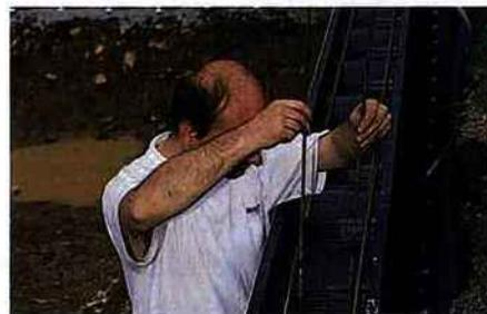
Mettre en place les aciers horizontaux du chaînage supérieur puis glisser les épingles verticales.
