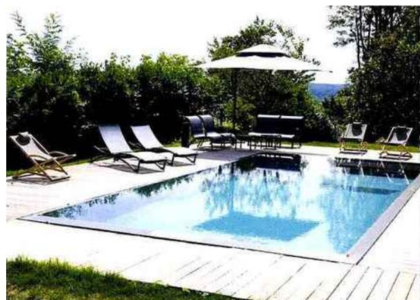
L'eau affleure au niveau des plages et s'écoule de façon homogène et constante sur les 4 côtés de la piscine *Miroir Ô* dans une goulotte de récupération La qualité de l'eau de baignade ainsi que la propreté du plan d'eau sont supérieures a une piscine équipée de skimmers de surface MONDIAL PISCINE
