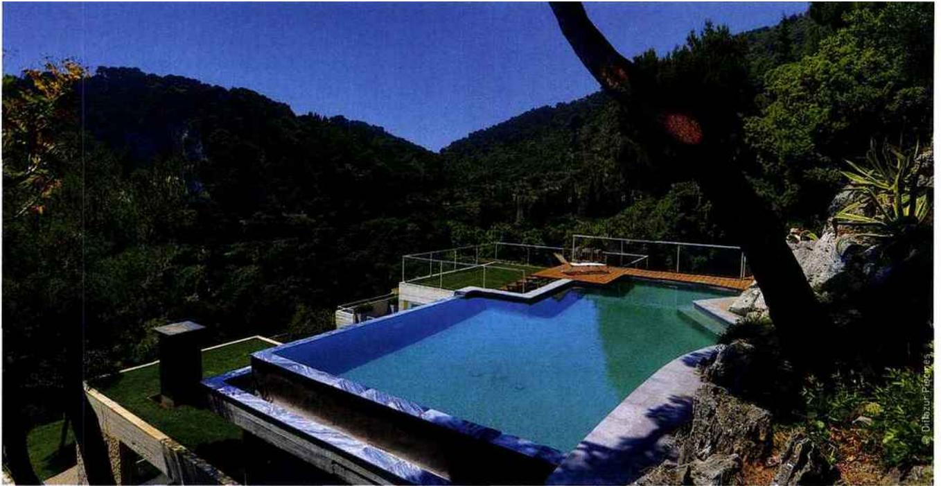
**Piscine avec vue** Médaille d'Or de la catégorie « Domestic Outdoor Pool » au concours européen de l'EUSA 2014, cette piscine de forme libre avec débordement sur deux angles, est construite en béton armé (Gunite). Elle mesure 11 x 5,5 x 4,5 m et sa profondeur va de 0,90 à 2 m. La combinaison de margelles rustiques et d'une plage en bois apporte un joli contraste à cette réalisation au paysage de rêve. *Diffazur Piscines*
